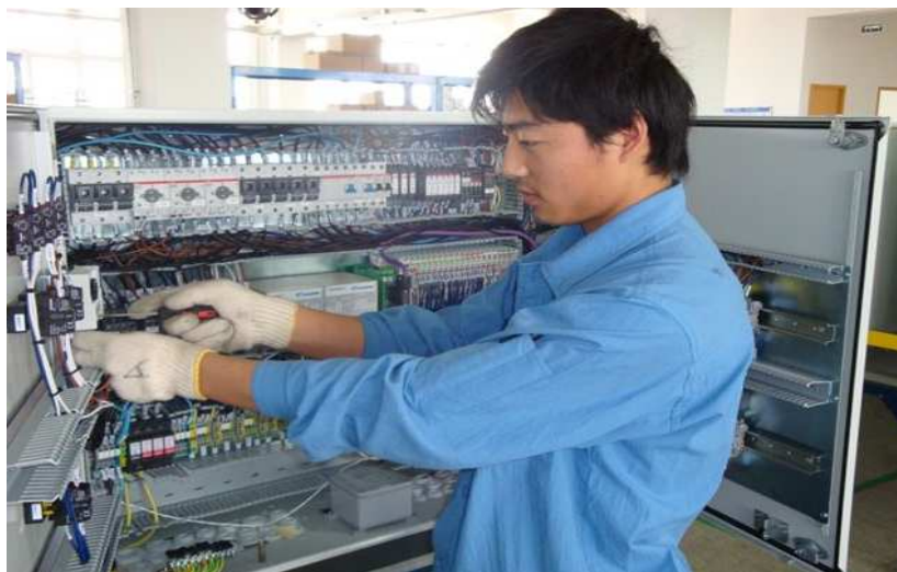
学生在电气实训工厂进行综合布线
