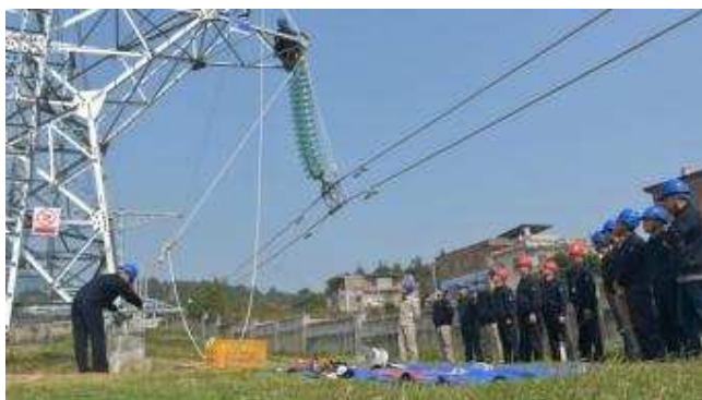
绳索化带电作业方式讲解
