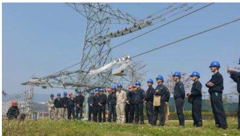
输电线路自动检修装置进行异物处理
