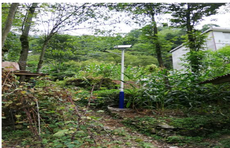
图 20：村间小路上安装好的太阳能路灯
