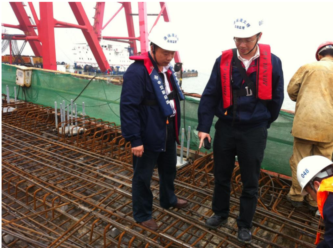
图 1-4 蒋伟平（左二）带队巡检港珠澳大桥岛隧工程
