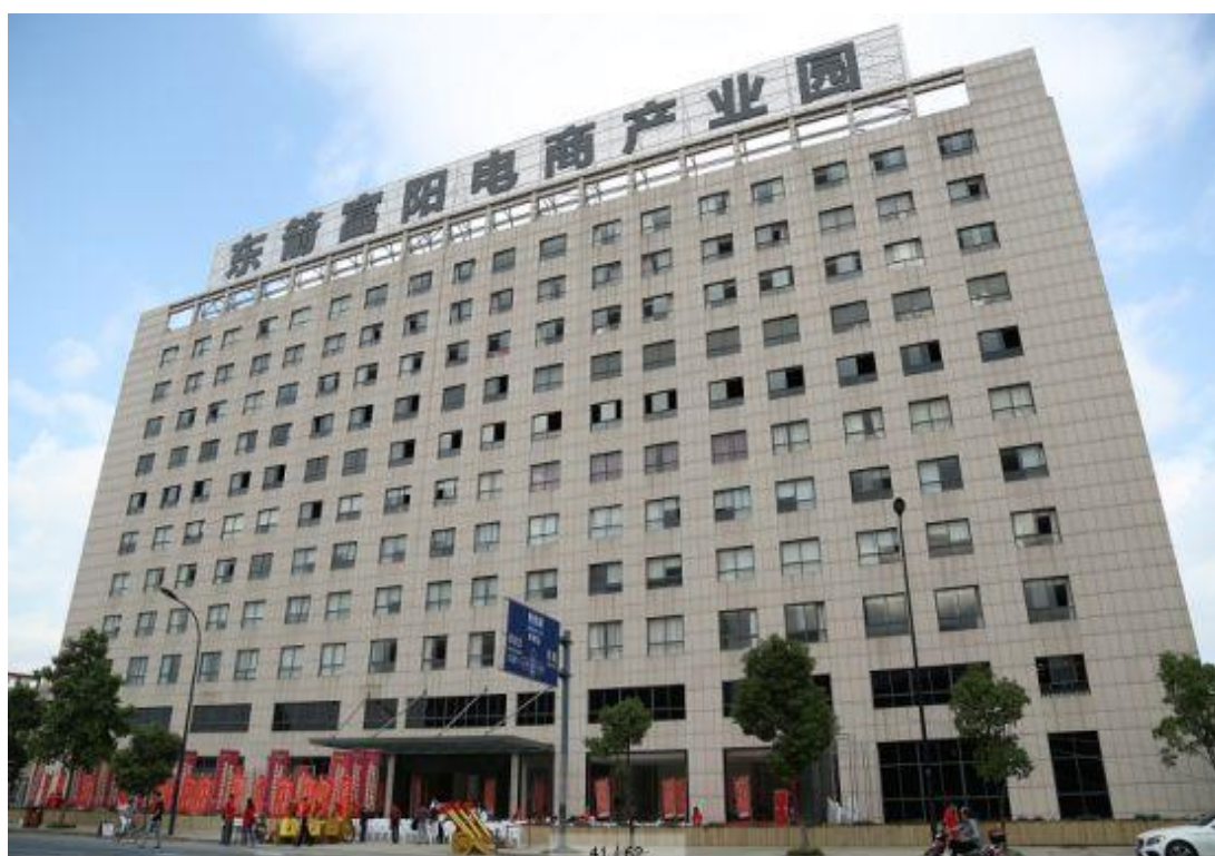
图 1 杭州富阳东箭电商产业园
