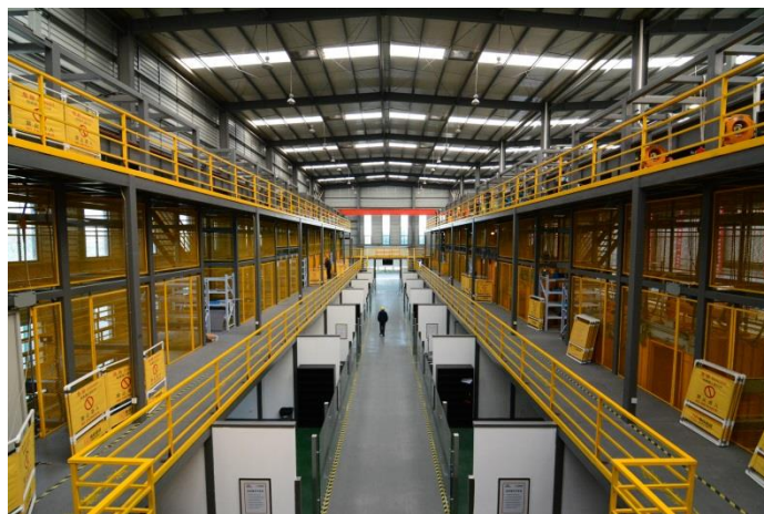
图 6 电梯实训基地
