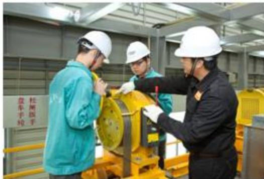
图 4 师傅指导徒弟进行电梯曳引机的维修
