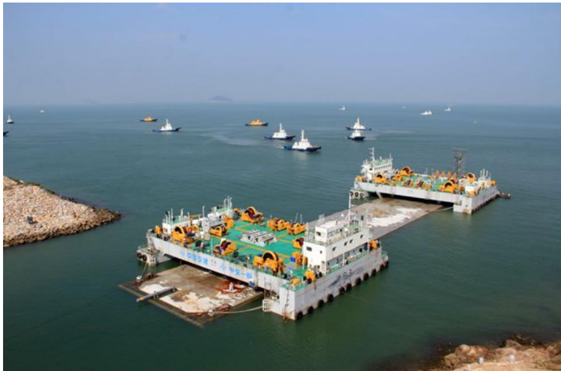
港珠澳大桥沉管运动姿态监测
