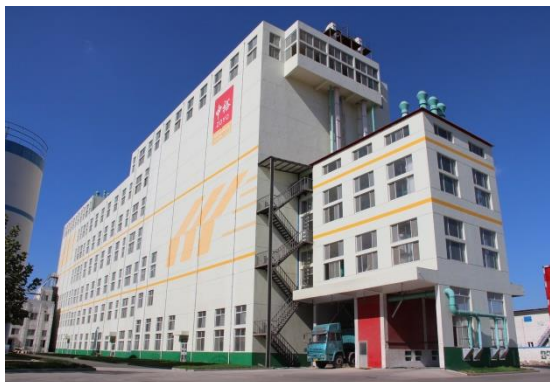
图 1 滨州中裕食品有限公司生产设施
