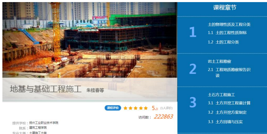
图4 精品在线开放课程《地基与基础工程施工》
