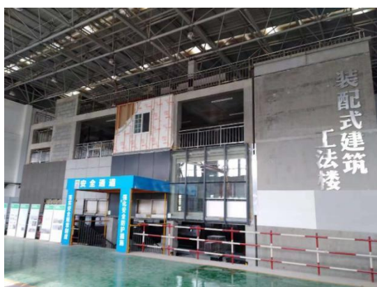
图 10 装配式建筑工法楼
