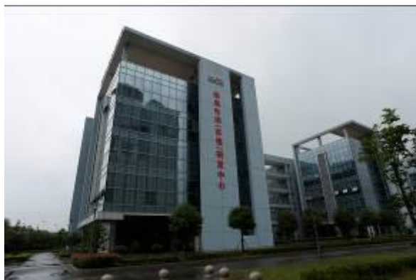
图 11 德奥电梯实训基地外貌
