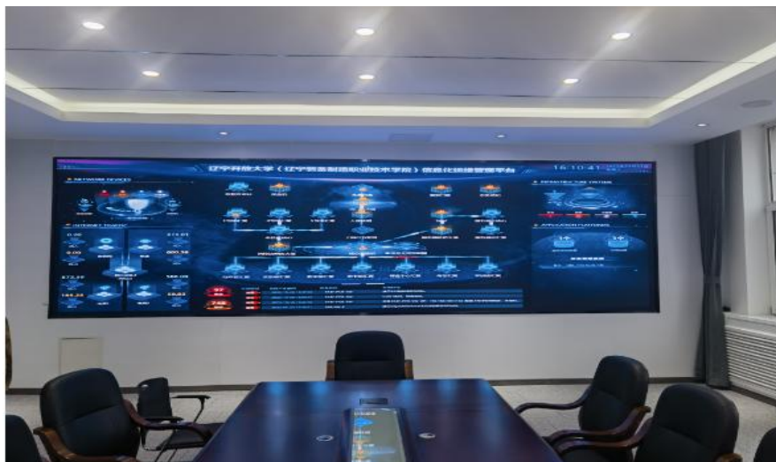
图 1-7 现代化数据中心
