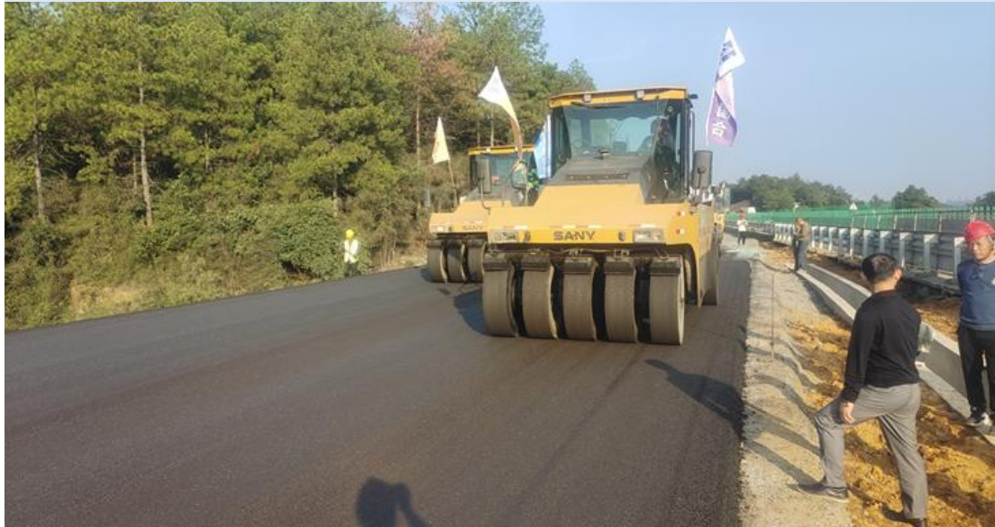
图 2-4 冷拌冷铺耐久性高性能沥青混凝土面层技术铺设的路面
