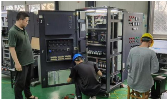
图 2-37 现代电器控制系统安装与调试赛训练
