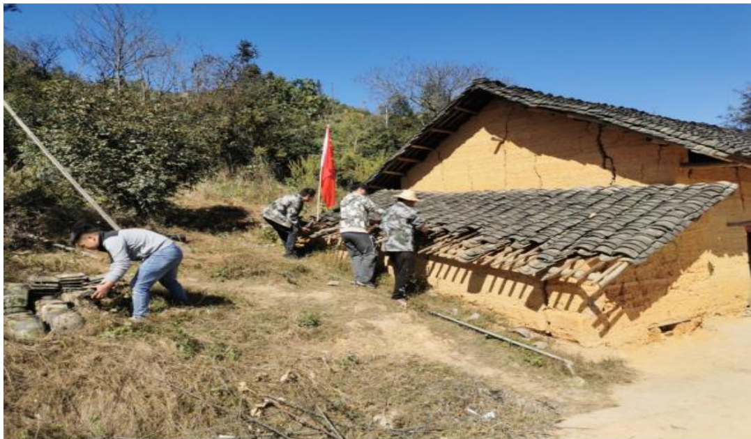
图 4-23 学院驻村队员帮助贫困户拆除土木危房
