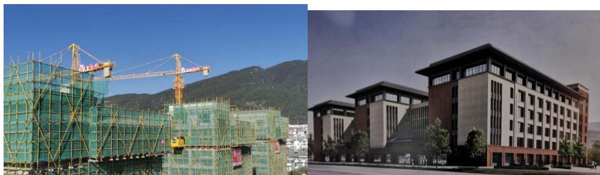
图 26 实验实训中心：施工及效果图
