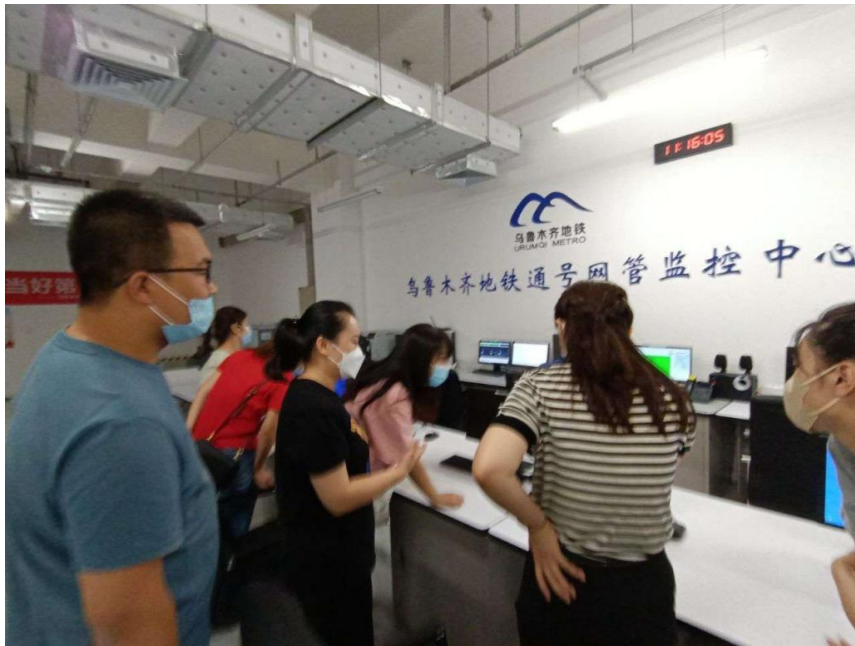
教材编写团队在地铁通号网管监控中心交流学习
