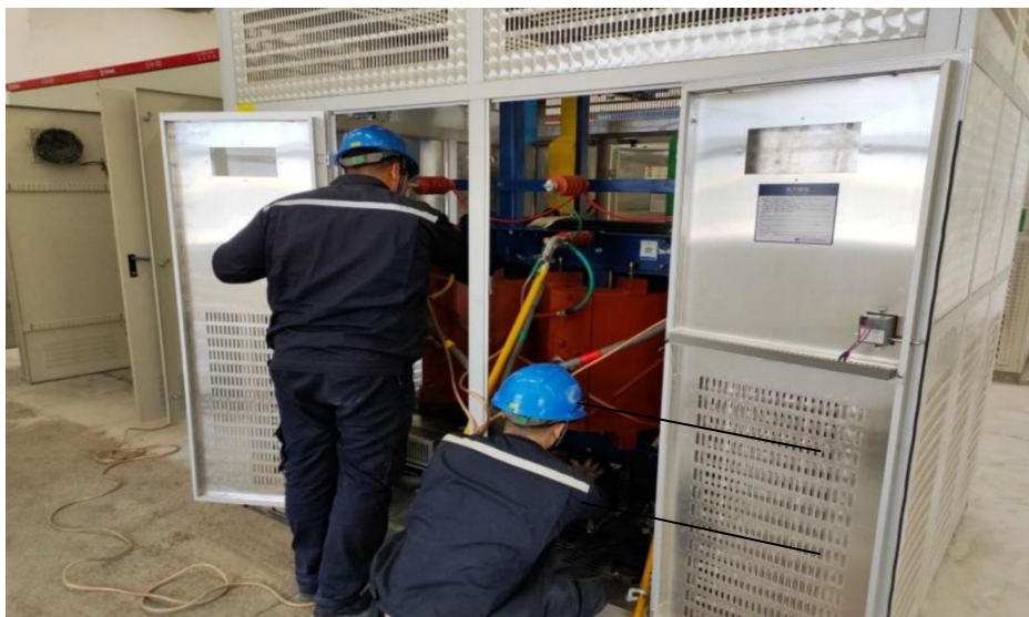
图 1.10 马小龙在维修设备
