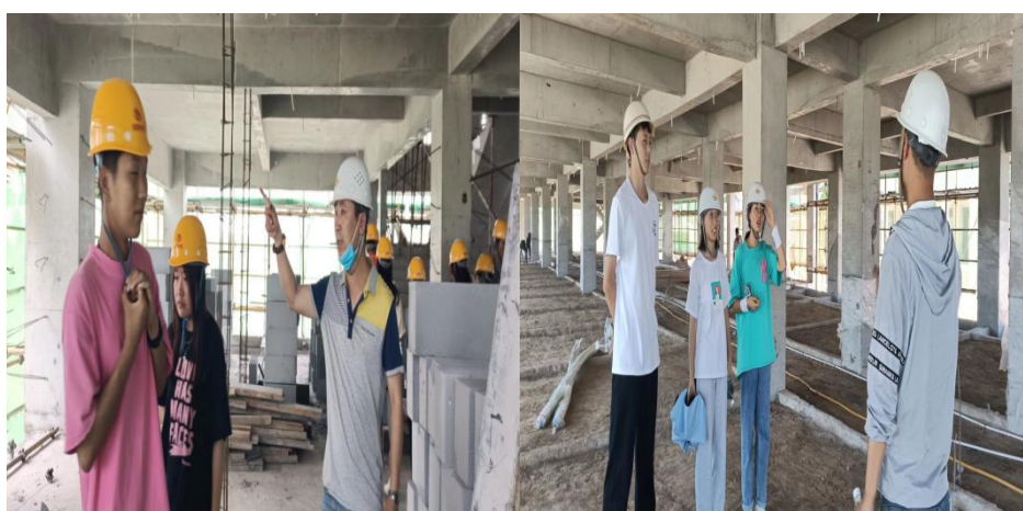
图 3-21、3-22 土木工程系学生在施工现场接受指导
