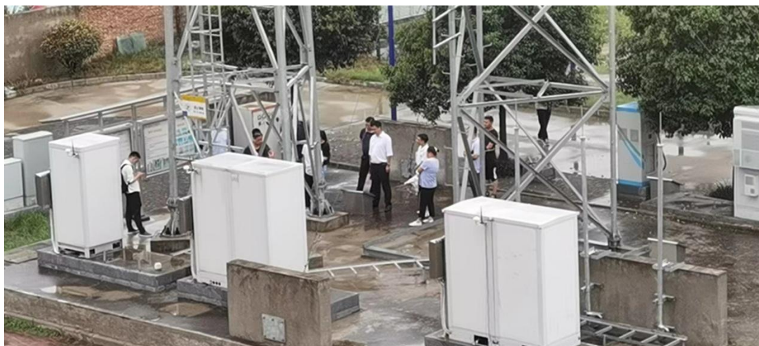
图 4.14 铁塔公司基站设备维护培训
