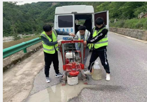
图 4-6 道路钻孔取样现场
