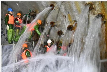
图 1-37 大柱山隧道建设者在处置涌水
