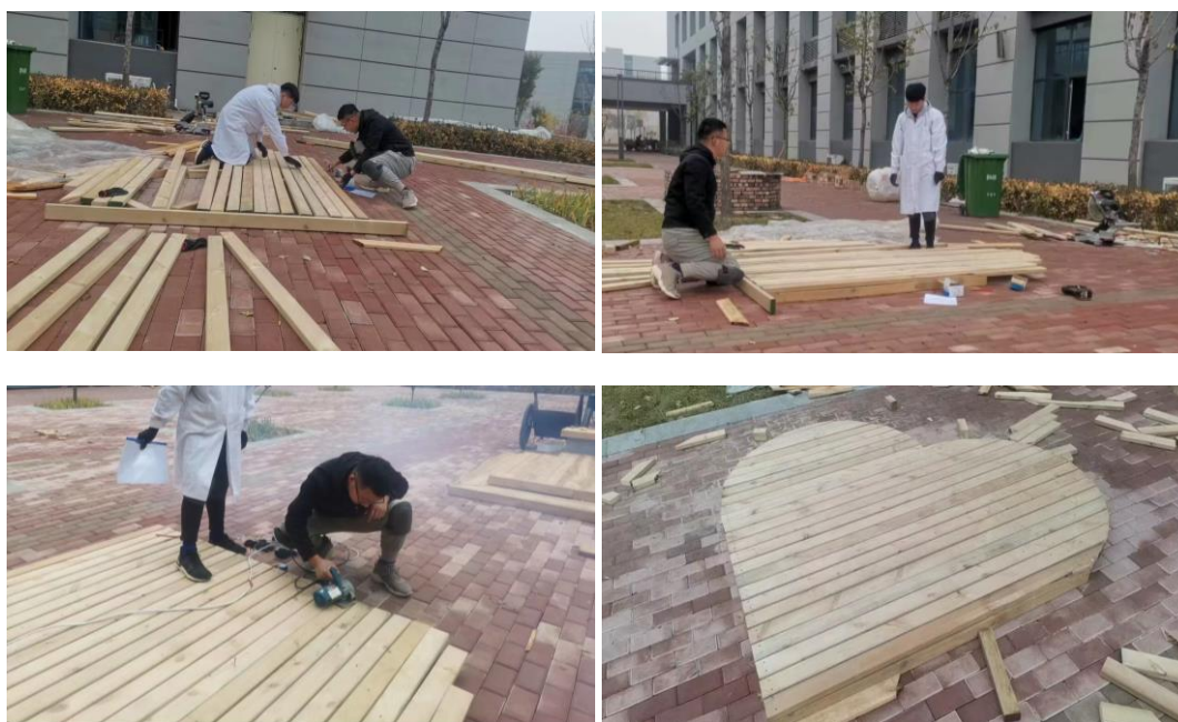
图 1-10 经过排版布面、边缘修整等工序搭建心形木台
