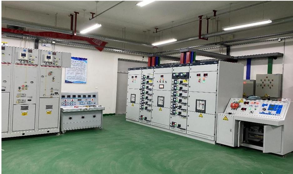
图 2-67 城市轨道交通变电所综合实训系统
