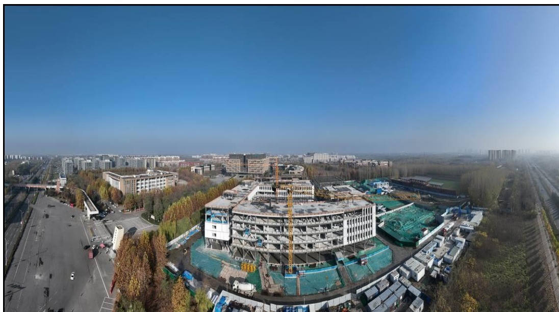
图 5-5 主体已完工的淄博装备智能制造实训基地，计划于2023年7月启用
