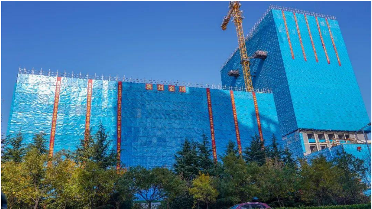
图 5-1 学院南校区工程主体结构建设全面完成
