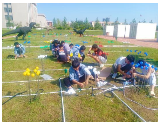
图 4-7 恐龙园亮化工程施工安装气球灯
