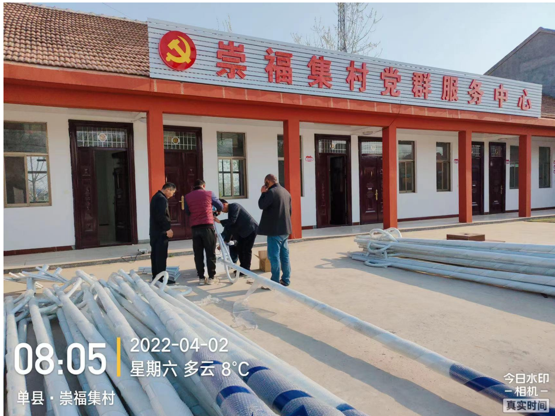
图 48 单县崇福集村路灯安装
