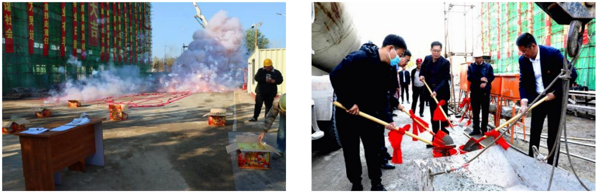
图 6-3 学校二期工程教学楼正式封顶仪式
