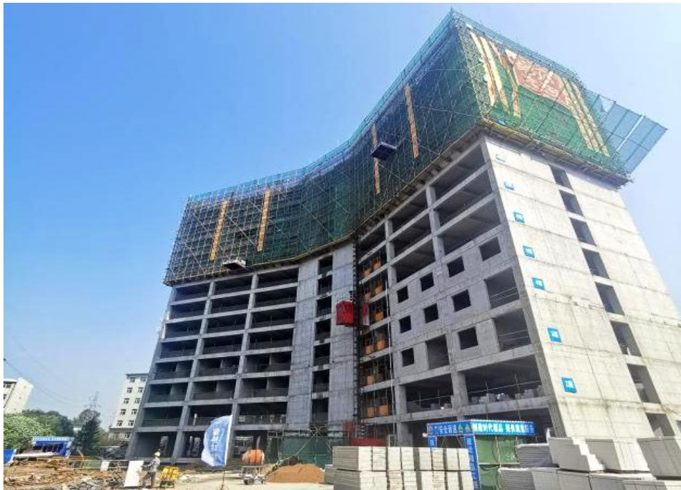
图 3- 8 新建学生宿舍现场施工实景
