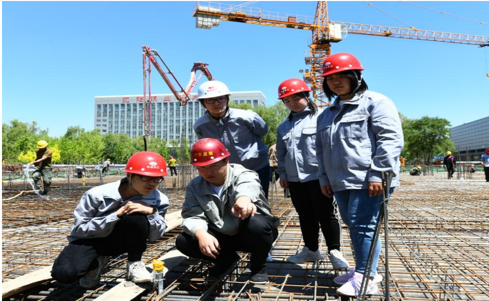
图 3- 16 企业师傅为 CSCI 学生讲解房屋楼板钢筋构造
