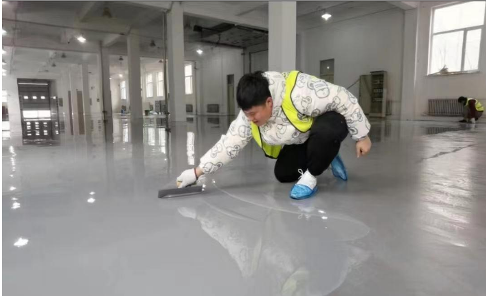
图 3- 20 学生进行环氧自流平面层刮涂实训
