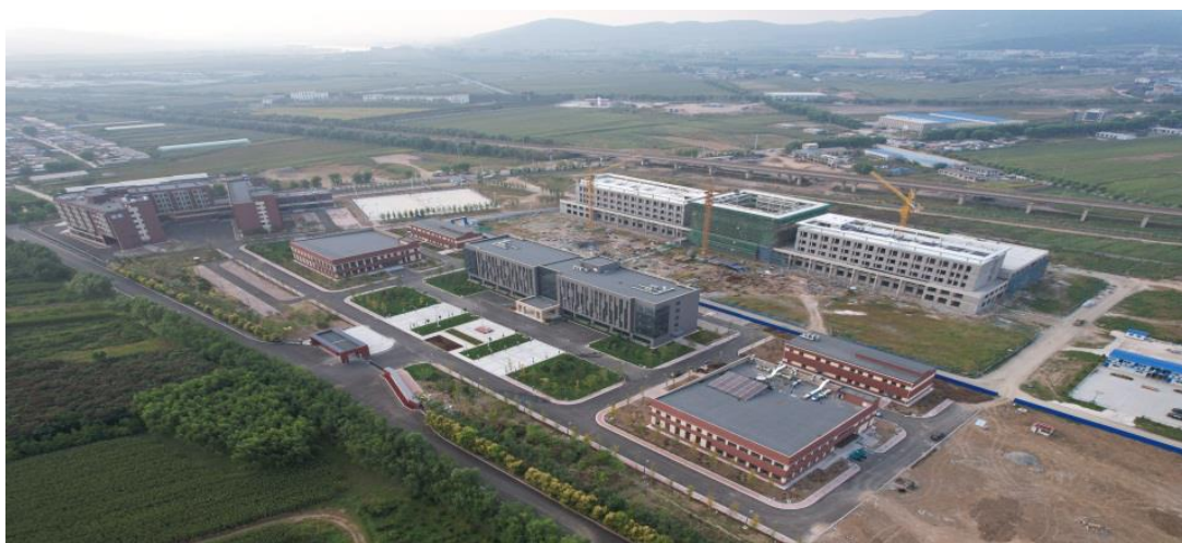
图 6-1 轨道交通产教融合中心实训基地建设全景
