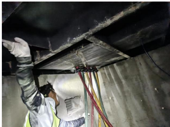
图 4-1 老挝学生宋克在检修列车牵引设备
