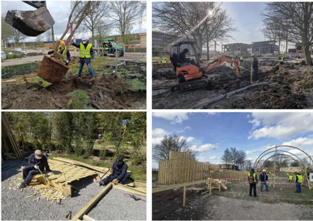
图 4-14 学校组建的校企混编建设团队在荷兰施工现场
