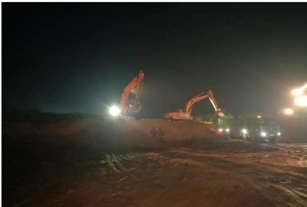
图9 建设方仓施工现场
