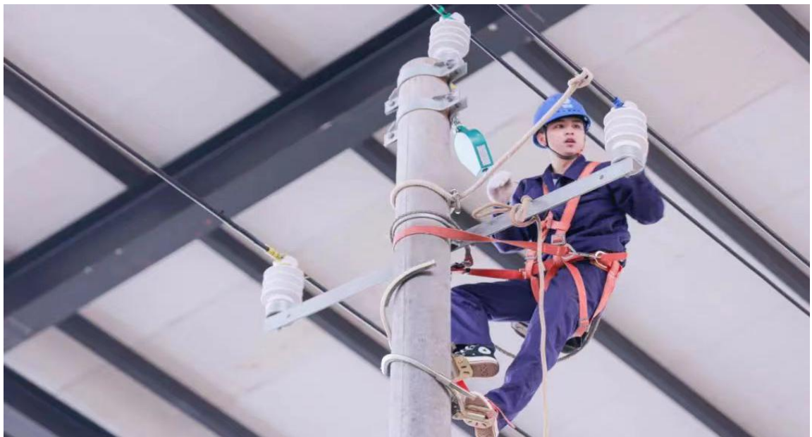
图 4-4 供电服务定向学生在进行登杆检修作业
