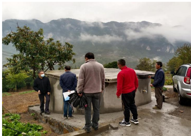
验收组查验新建蓄水池
