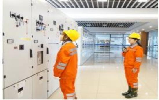
69 图 3-48 三工位开关倒闸操作过程
