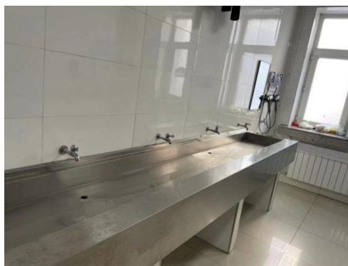
学生公寓洗漱间维修改造
