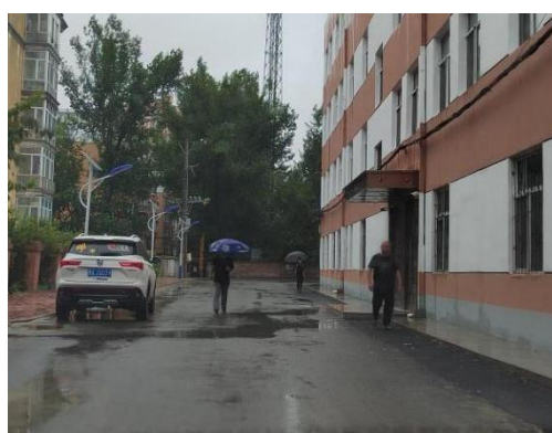
老尚号厂区路面铺设
