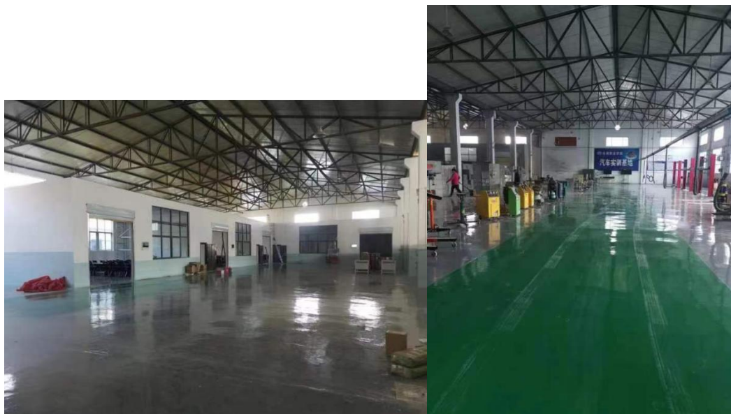
图 1：升级改造中的汽车维修与检测实训基地
