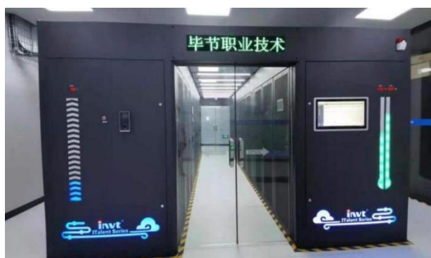
图 3-11 学校信息中心机房建设现场图
