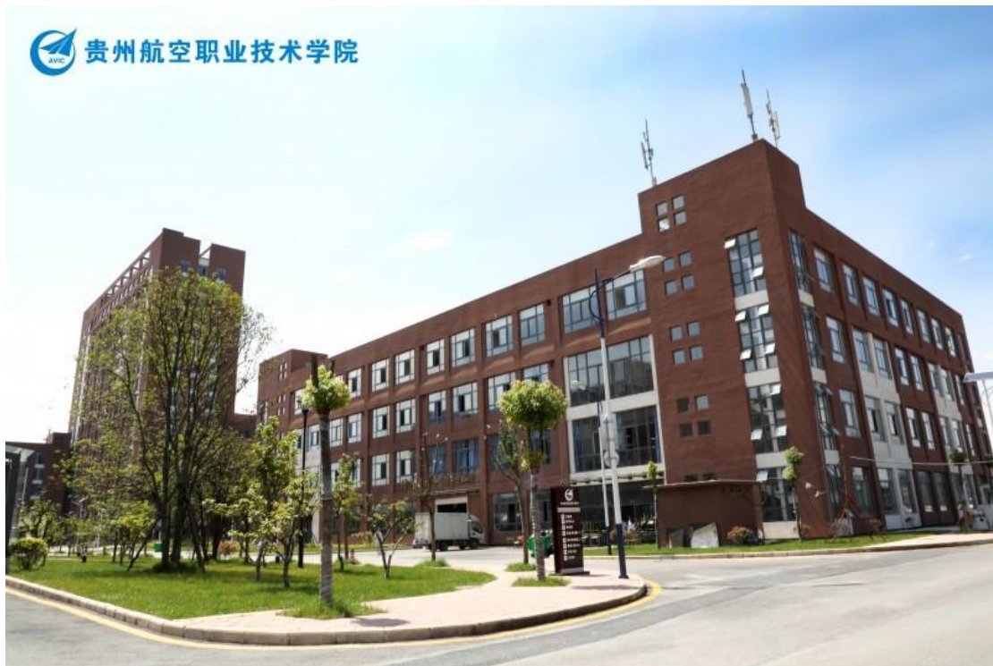
图 3-5 智能制造综合实训大楼
