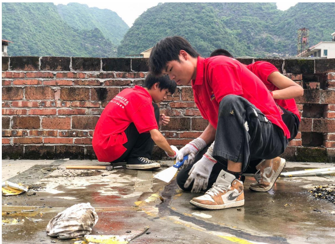
图 5-13 实践团成员清除裂缝对村民房屋进行修缮
