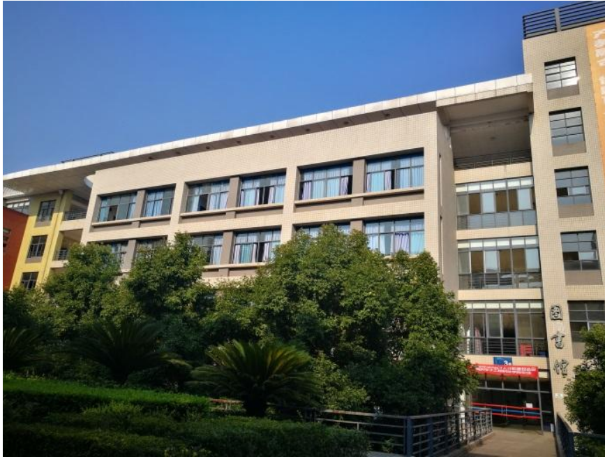
图 6-8 校舍建筑物外观、用材
