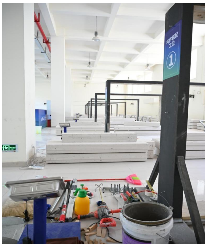
图 5.1 装配式墙板安装实训场地
