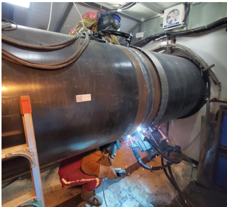
图10 学生实习期参与国家大型工程项目焊接施工
