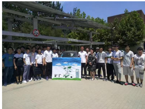
师生共同完成安装、调试工作
