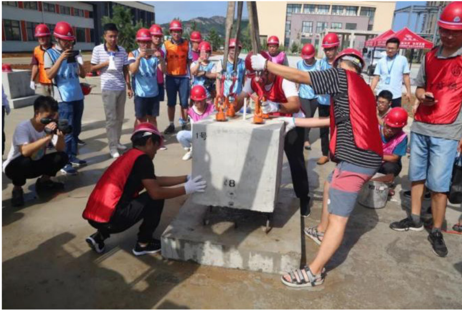
图 4 装配式建筑关键技术一套筒灌浆培训
