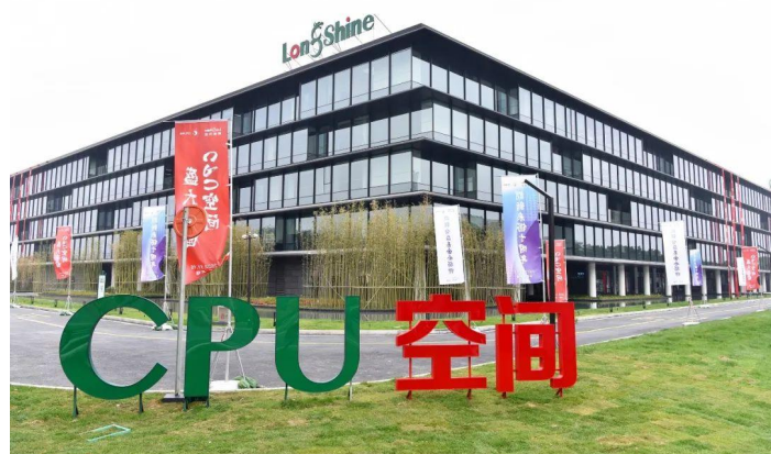
图 1 朗新科技集团股份有限公司 CPU 空间基地
