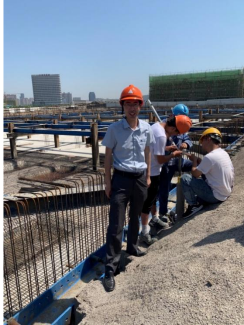
图 8 校企合作完成建筑物基坑监测项目
