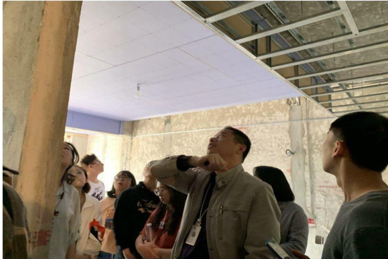
图4 “品清”现代学徒班施工现场教学
