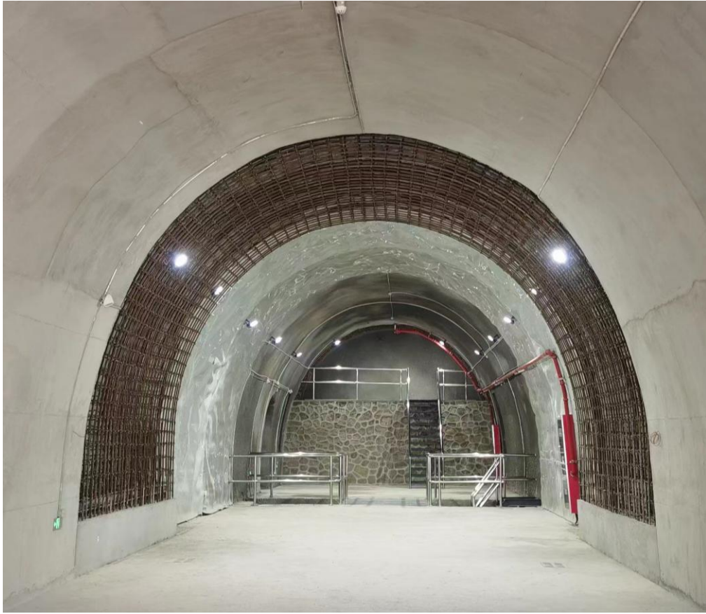
图3 合作共建地下与隧道实训基地
